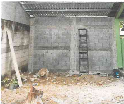
SUSTITUCION DE MURO PERIMETRAL
