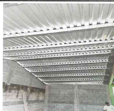
Techado en parte trasera del establecimiento
