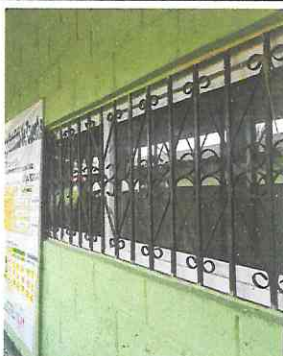
Instalacion de Ventanas de PVC
